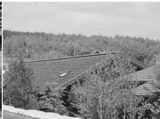
手前の黒い平屋建てが「ゼロエミッションハウス」、南の屋根に太陽光発電システム、北の屋根にはスナゴケで緑化。どちらも屋根材と一体化させることでデザイン・景観も考慮した設計に。（積水ハウス）左、後方に見えるのが国際メディアセンター。
