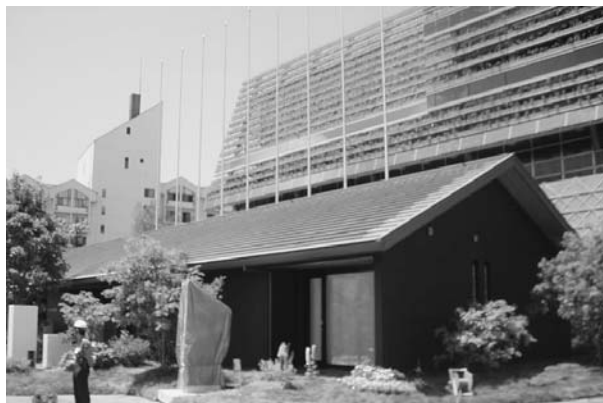
手前の黒い平屋建てが「ゼロエミッションハウス」、南の屋根に太陽光発電システム、北の屋根にはスナゴケで緑化。どちらも屋根材と一体化させることでデザイン・景観も考慮した設計に。（積水ハウス）左、後方に見えるのが国際メディアセンター。
